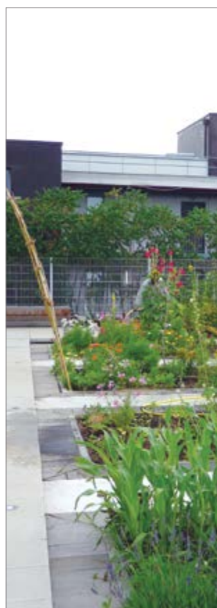
Jardin sur le toit d'un gymnase, rue des Vignoles (Paris XX e )
