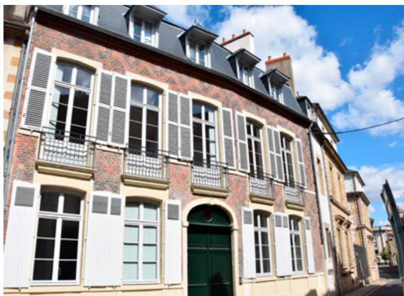
L'ancien rez-de-chaussée commercial a été transformé en logements accessibles aux personnes à mobilités réduites.
