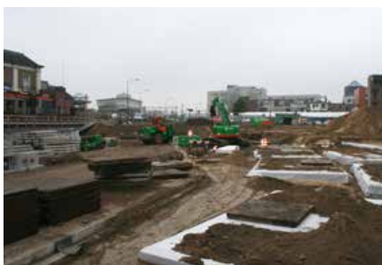
Îlots remplis de terre et couverts d'un géotextile.
