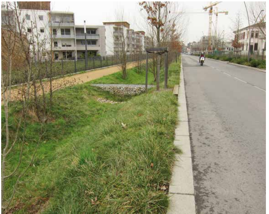
Noue entre chaussée et trottoir à Sathonay près de Lyon, France. Image : Richard Barnes
