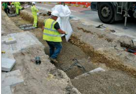
Mise en place de la couche de drainage et du système de haubanage des mottes (voir l'étude de cas n°2 p. 30).
