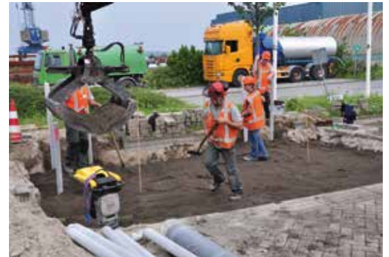
Application en couches de 30 cm du substrat constitué de matériaux recyclés et compactage de chaque couche à l'aide d'une pilonneuse.
