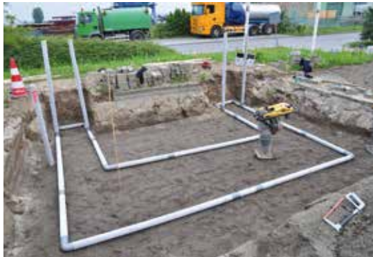
Excavation réalisée et système d'aération en place.
