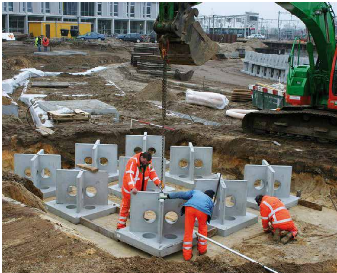
Positionnement des caissons en béton sur des îlots préalablement terrassés et compactés sur la place de la Gare à Apeldoorn (voir étude de cas n°24 p. 129).
