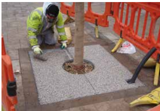
Installation d'une grille remplie d'enrobé à la résine sur Ocean Road (voir l'étude de cas n°2, p. 30). Image : South Council Tyneside
