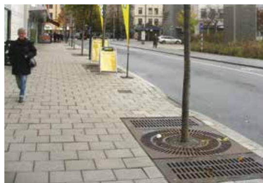
Grille en fonte ductile dans une rue de Stockholm en Suède offrant une large surface pour faciliter l'échange gazeux et l'approvisionnement en eau de la zone d'enracinement.
