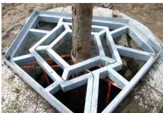
Cadre nu et produit fini pour ces grilles de pied d'arbre conçues sur mesure pour la place de la gare à Apeldoorn aux Pays-Bas (voir l'étude de cas n°24, p. 129). Images : Ron van Raam (à gauche) et Jeremy Barrell (à droite)
