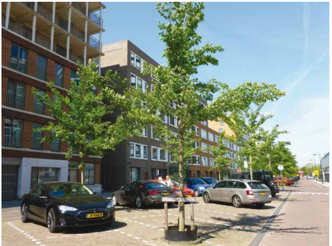
Dans ce parking situé à Amsterdam aux Pays-Bas, un revêtement perméable a été posé sur un système flottant (Permavoid) pour garantir aux arbres un espace d'enracinement non-compacté et également efficace pour l'infiltration des eaux de pluie. Image : Anne Jaluzot
