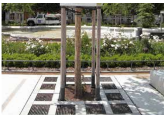
Grille d'arbre avec empiérement calcaire disposée en travers de la circulation pour éviter aux piétons de glisser sur les rainures, place Bellecour à Lyon.
