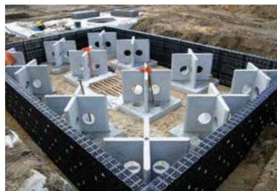
Cet îlot est prêt à être rempli de terre.
